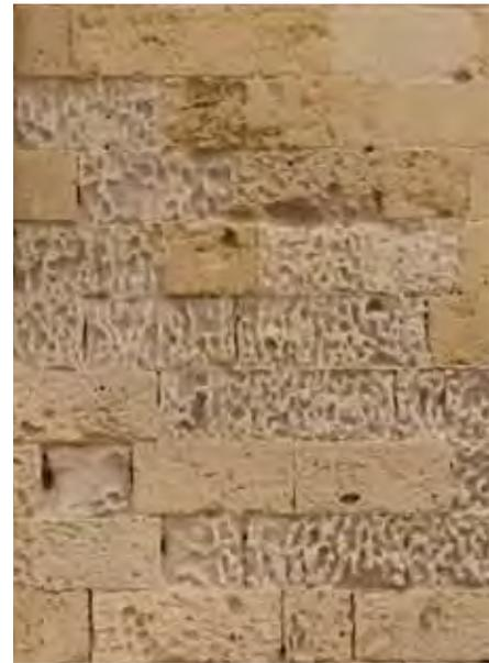
Figura 2: Alveolizzazione di una muratura nei Sassi di Matera
