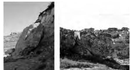
Fig. 01 - a) distacco e scivolamento di un blocco calcarenitico avvenuto nel giugno 2003; b) blocchi calcarenitici molto fessurati, dislocati o in evidente stabilità precaria
