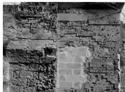
Fig. 4, Segni della stratificazione delle fasi di intervento in un paramento murario dei Sassi
